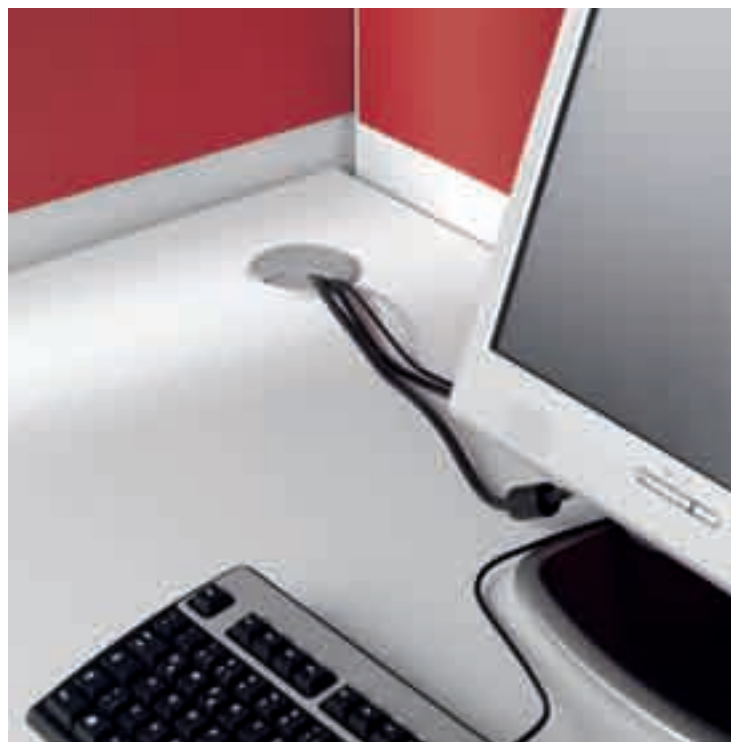
Przelotka w blacie biurka do prowadzenia kabli.
